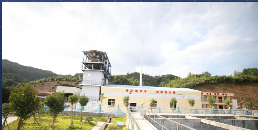
采用本公司的专利设备圆柱型多棱多层发酵塔，实行多层发酵，高温破膜，分层布风供氧，零能耗重力翻堆，逐层除湿排气，两次发酵，完成污泥生物发酵干化工序。
